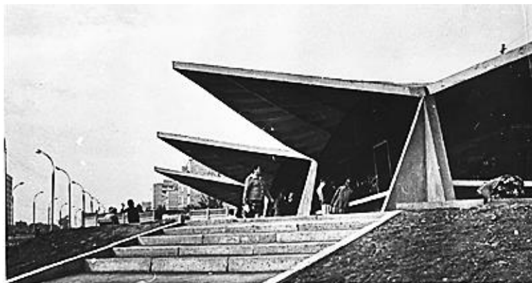
Рис. 3. Сборное составное гиперболическое покрытие рынка (размер 36×24 м)
